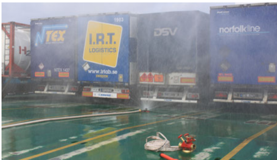
Brandskyddsroren hindrar elden från att sprida sig. Foto: Antti Aittola.
