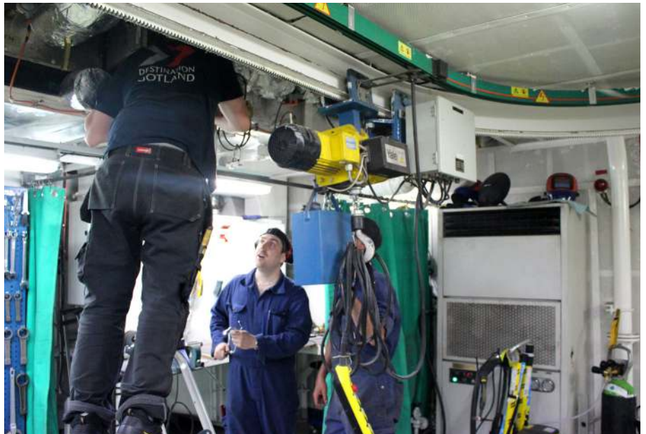
M/S Visborg har gått i trafik sedan i våras, men arbetet med att bygga upp förråd och anpassa arbetsutrymmen ombord kommer att pågå länge till.
